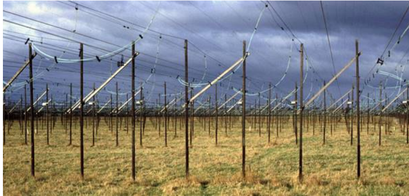
Figura 1: Aqui está o radiotelescópio. Os postes de madeira mantêm os fios de cobre desencapados afastados da grama. As antenas capturam os sinais que percorrem os laços do fio e os enviam de volta aos receptores no laboratório.
