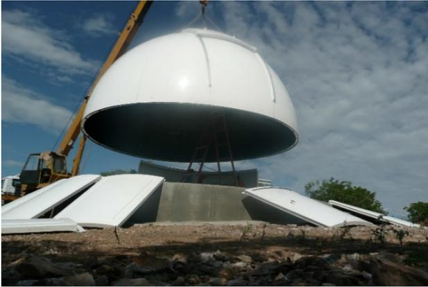
**Figura 1:** Montagem da Cúpula.
