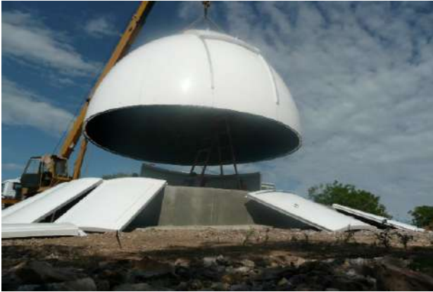
Figura 1: Montagem da Cúpula.
