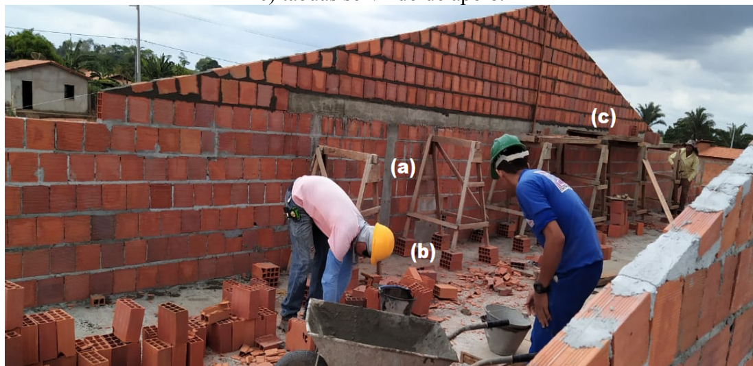
Figura 2. a) utilização de cavaletes substituindo andaimes, b) cavaletes sustentados por tijolos, c) tábuas servindo de apoio.
