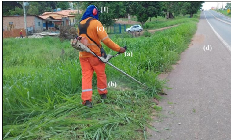
Figura 1. Inconformidades encontradas no trabalhador [1]: ausência de (a) luvas, (b) caneleira, (c) vestimentas para proteção do tronco e (d) local de trabalho sem sinalização adequada.
