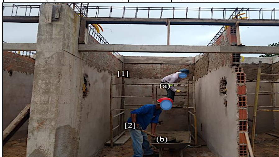
Figura 1. Inconformidade encontrada nos funcionários [1] e [2]: má postura (a) em tarefas repetitivas e (b) levantamento de peso em repetidas vezes no mesmo local.
