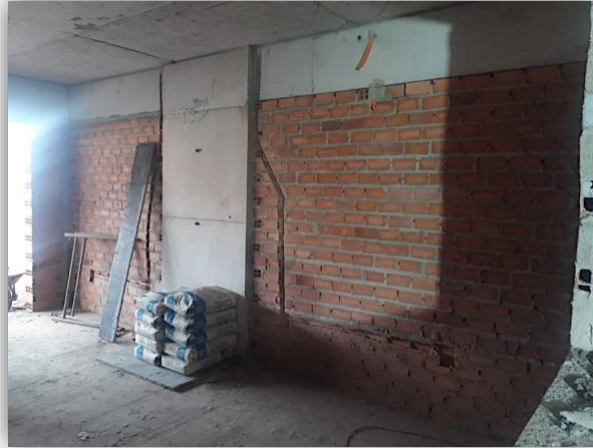
Figura 1. Corte da parede para passagem de corrugado
