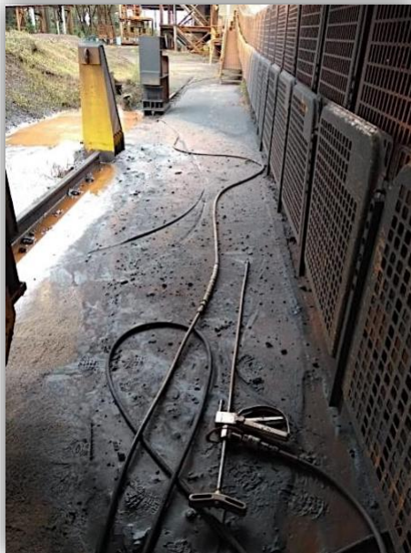
Figura 13. Piso escorregadio no pátio de estocagem.
