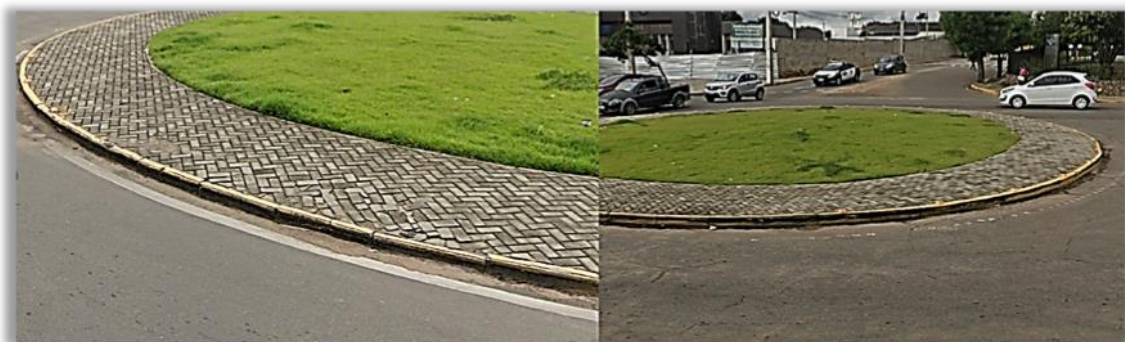
Figura 13. Registro do contato dos veículos de grande porte na praça central da rotatória como consequência a realização de conversões à direita ou à esquerda
