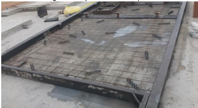
Figura 6. Locação da armadura do painel
