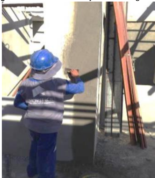
Figura 15. Acabamento das juntas com argamassa
