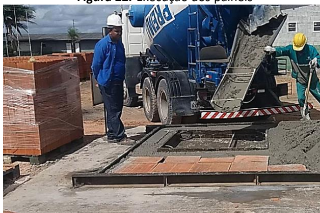
Figura 22. Execução dos painéis
