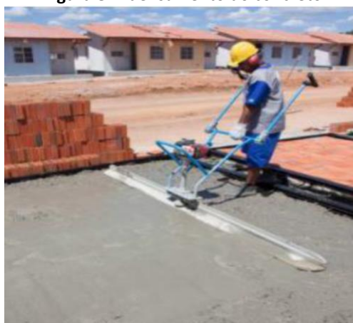
Figura 8. Adensamento do concreto
