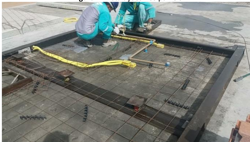
Figura 7. Instalações nos painéis
