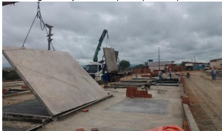
Figura 12. Içamento dos painéis para transporte
