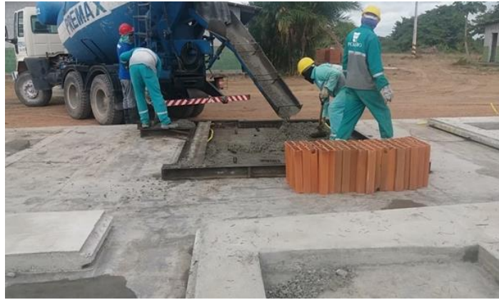
Figura 17. Descarga de concreto dentro da forma
