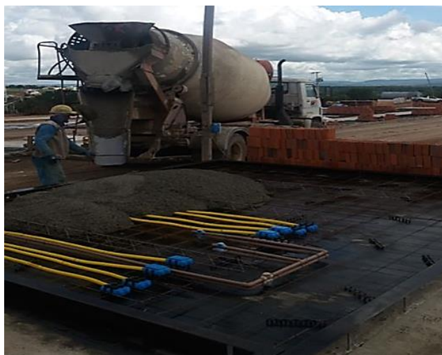
Figura 18. Instalações elétricas e hidráulicas no painel
