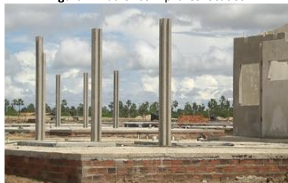
Figura 2. Radier com pilares locados
