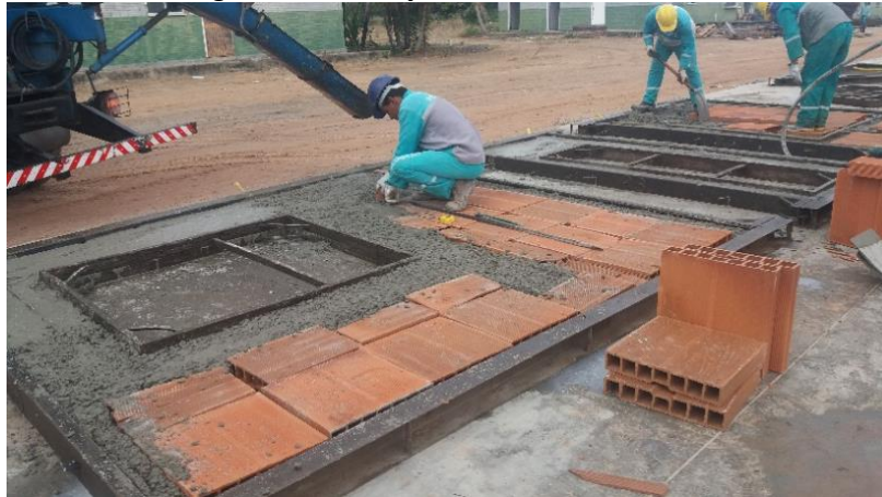
Figura 9. Distribuição dos blocos cerâmicos
