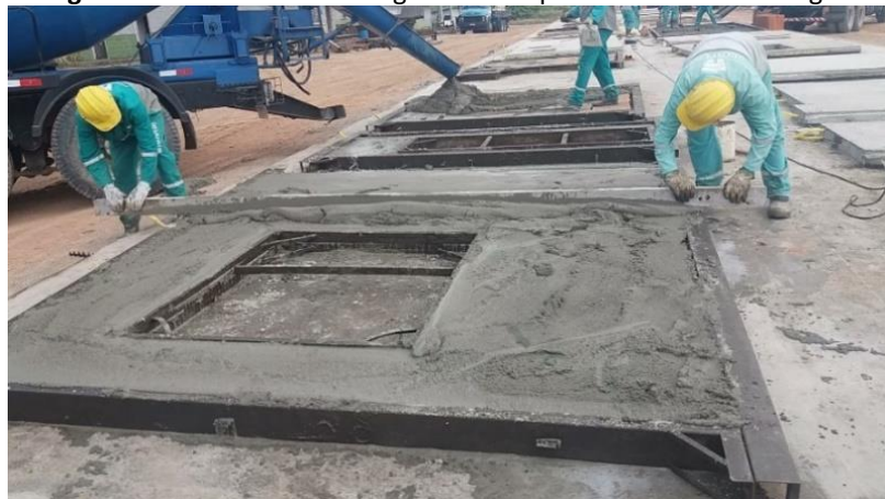
Figura 10. Acabamento de argamassa do painel com o uso de régua
