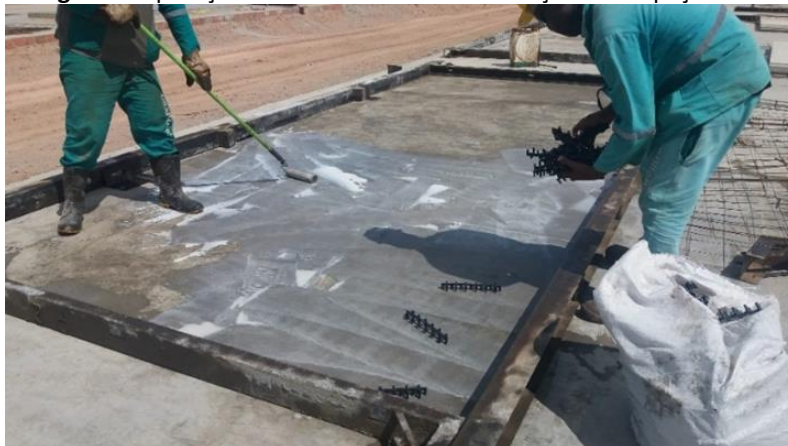
Figura 5. Aplicação do desmoldante e distribuição dos espaçadores
