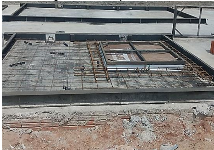
Figura 19. Painel com janela instalada
