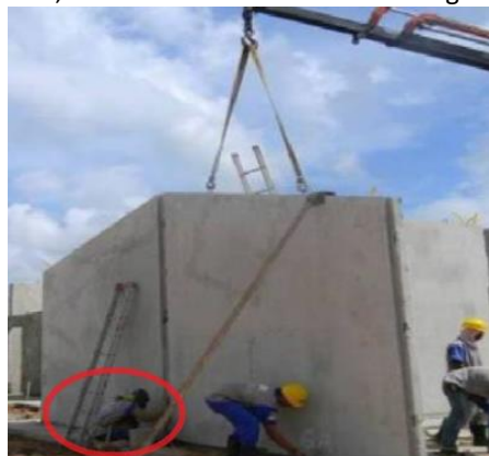
Figura 13. Pannel escorado, sendo feito o acabamento na argamassa de assentamento
