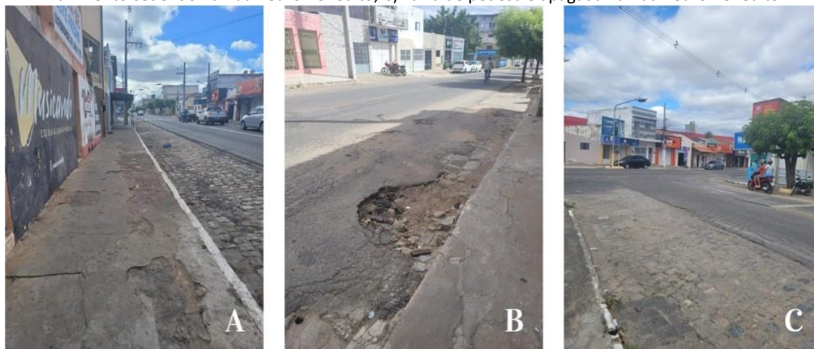
Figura 8. Imagens das condições de infraestrutura das vias. A) Calçada desgastada na Rua Lima Campos; B) Pavimento cedendo na Rua Pedro Benedito; C) Faixa de pedestre apagada na Rua Pedro Benedito
