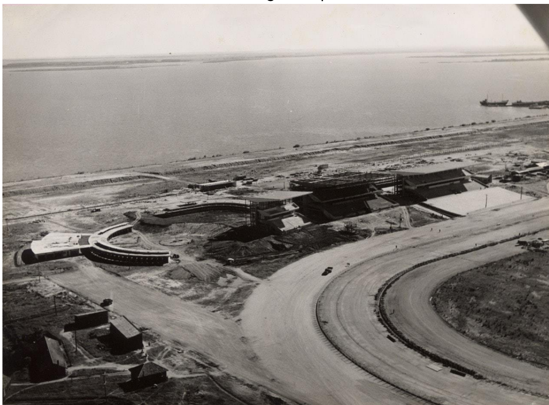
Fotografia: autor desconhecido. Construção do Hipódromo do Cristal, 1958.
