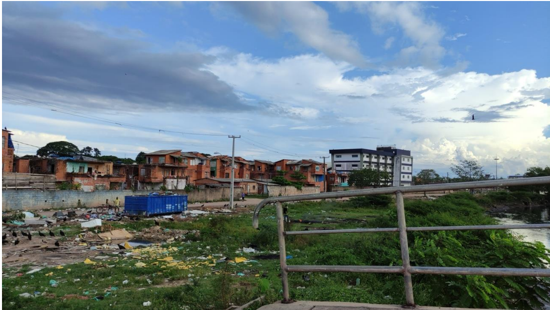
Conjunto habitacional popular na beira do Tucunduba, canalizado, com vegetação, lixo e urubus espalhados.
