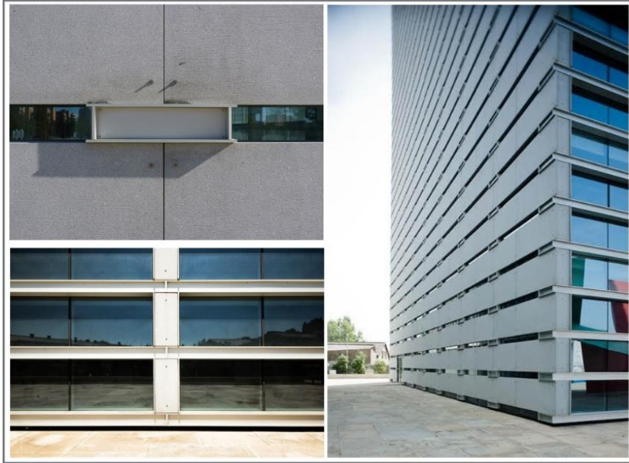
Figura 5: Detalhes constitutivos das fachadas da Torre de Burgo que caracterizam o envolvimento do edifício. Fonte: www.pinimg.com (2016).
