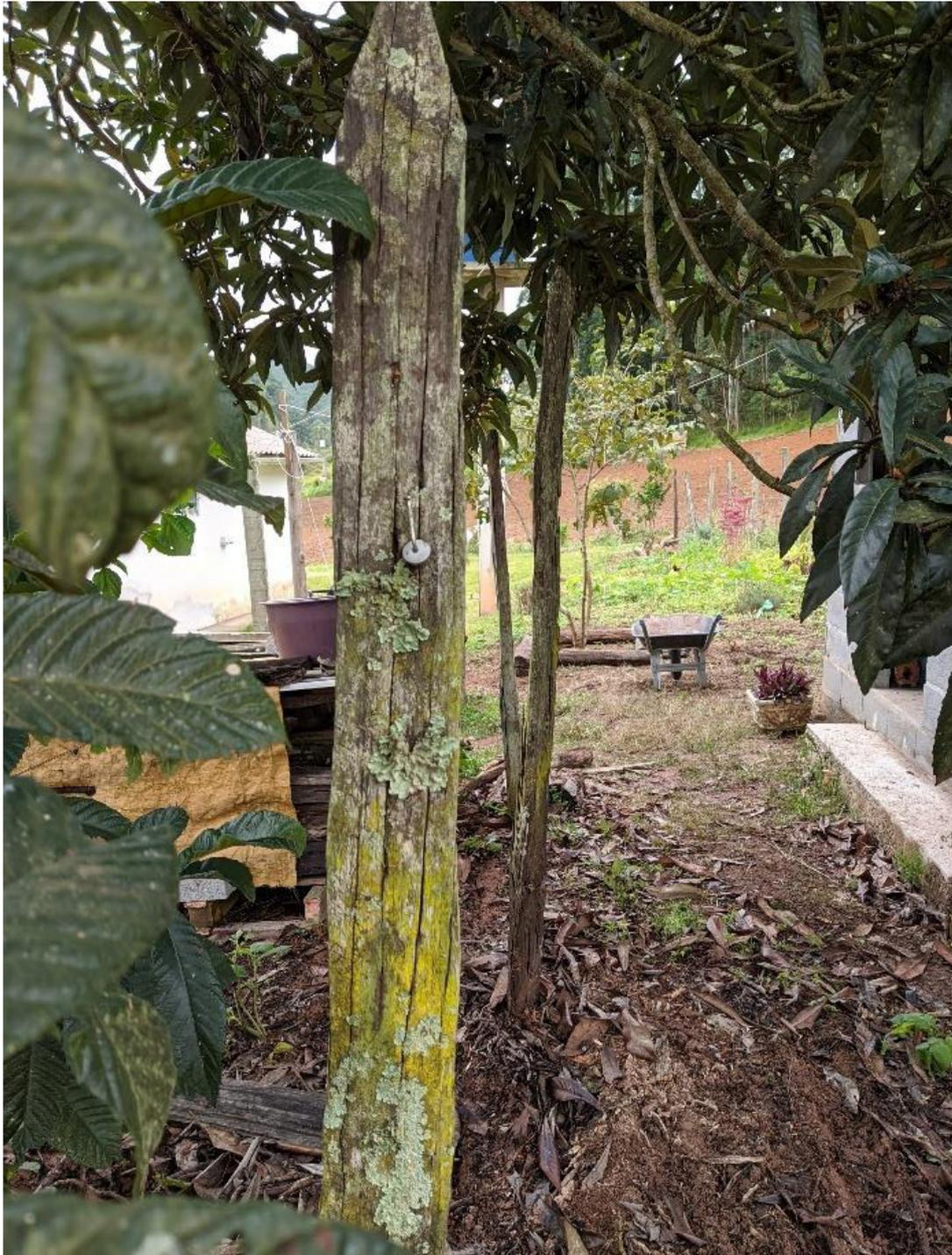
Figura 25. Lascas de braúna. Detalhe de três mourões da antiga cerca, da década de 1990, retirada em 2020.
