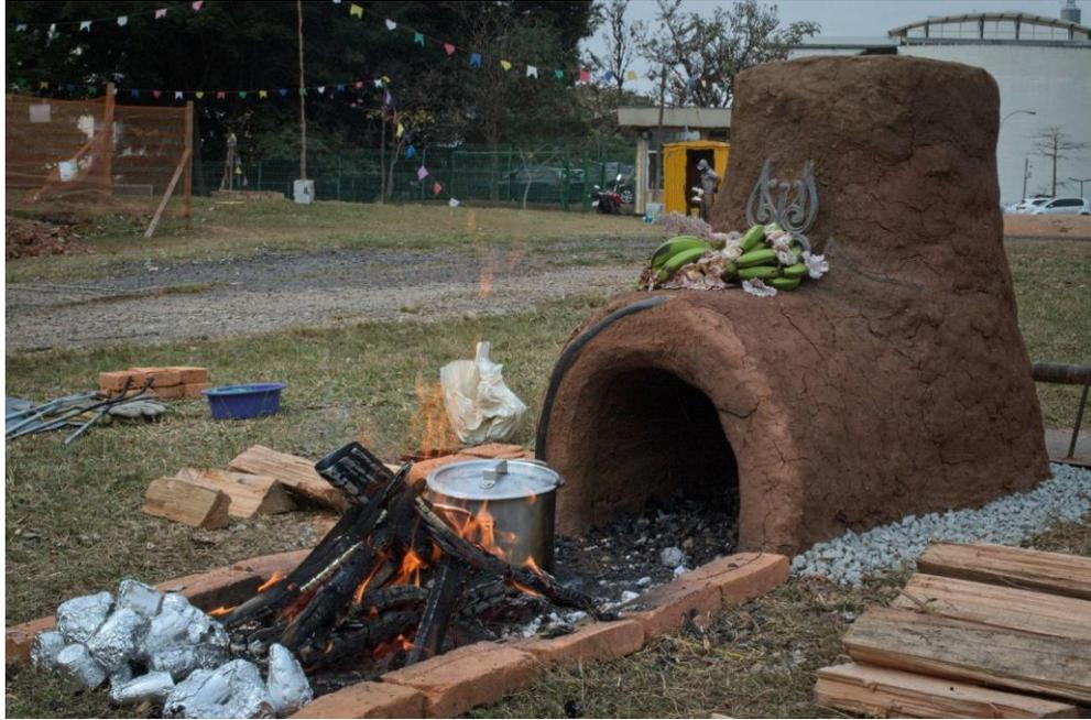
Figura 05. Forno Joana de Barro construído e adornado. Fonte: fotografia por Brunno Figueiredo Rodrigues. A imagem mostra um forno à lenha construído de tijolos e adobe. Na frente do forno, é possível ver chama de fogo, lenha e uma panela de alumínio.
