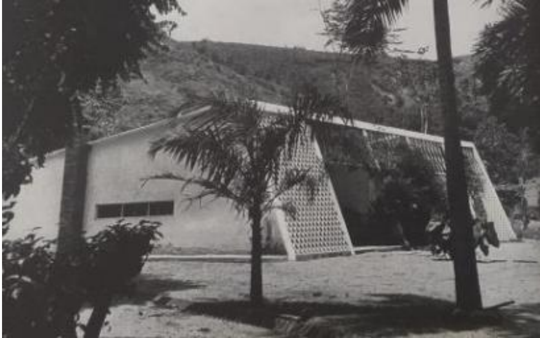
Figura 3. Foto da Casa de Mendes, de Oscar Niemeyer (1907, Rio de Janeiro - 2012, Rio de Janeiro). Na imagem em preto e branco, a foto é feita de um ângulo externo, na altura do ângulo de visão de uma pessoa em pé. A casa possui quinas que não descem perpendicularmente ao chão, mas fazem ângulos mais abertos. Vê-se ainda o entorno arborizado, além de um fundo de montanha coberta de mata. Fim da descrição. Fonte: Papadaki, 1950, p. 196.
