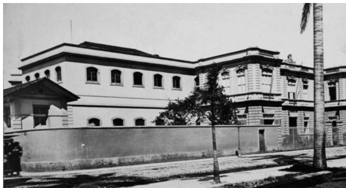
FIGURA 2: Fachada do Hospital Escola São Francisco de Assis já adaptado para receber o uso hospitalar. Fonte: UFRJ (2013)
