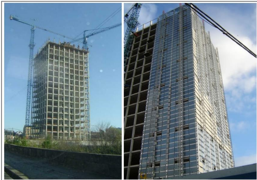
Figura 6: Imagens da construção da Torre de Burgo. Fonte: www.grupo-sanjose.com (2016).
