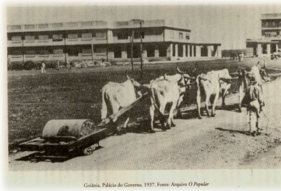
Figura 2 - Construção do Palácio do Governo em Goiânia, a nova capital (1937) 2
