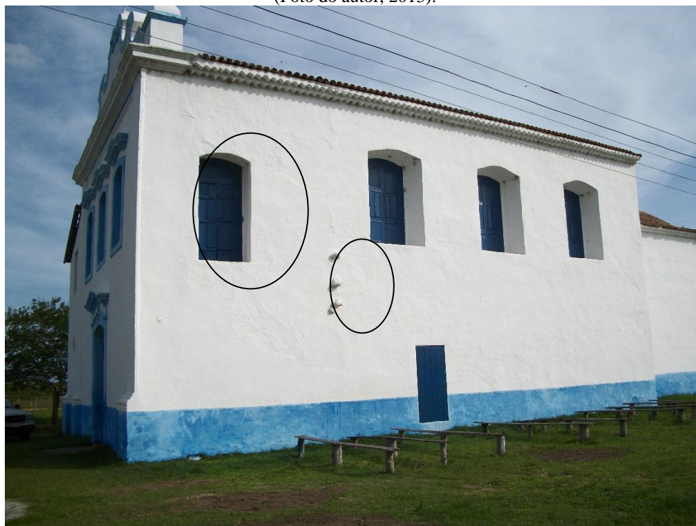
Figura 5 - Na fachada lateral esquerda, a presença de uma porta ao alto, de acesso ao coral (no círculo maior), e três elementos proeminentes (no círculo menor) sugerem a existência de uma ligação anterior com outro edifício (Foto do autor, 2013).
