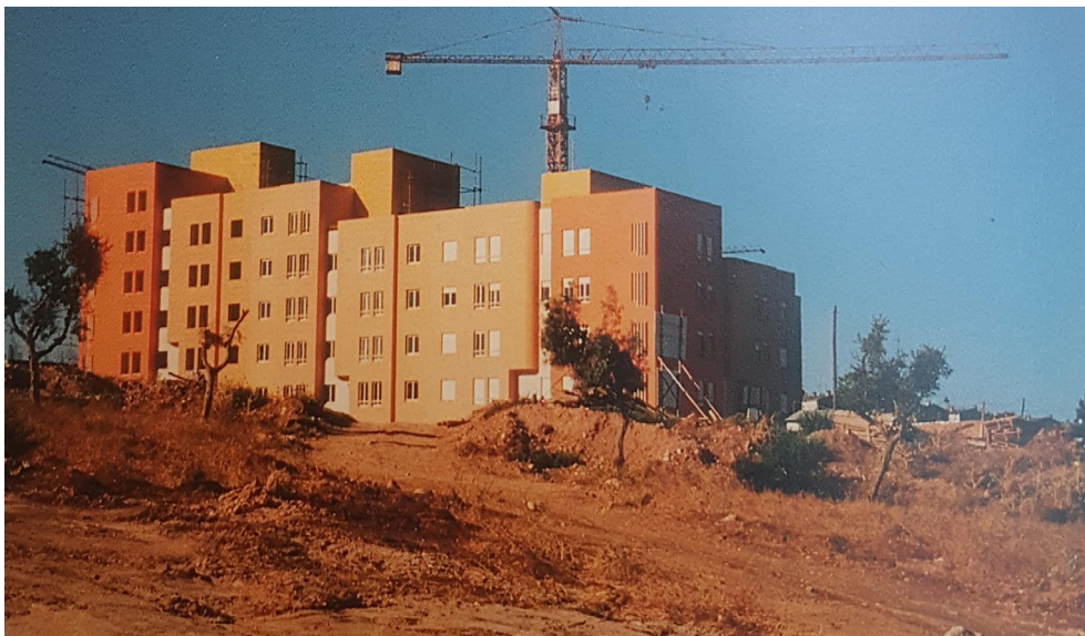
Figura 5 – Bairro novo em construção. Fonte: Boletim do GTH. Lisboa, nº 52, 1990
