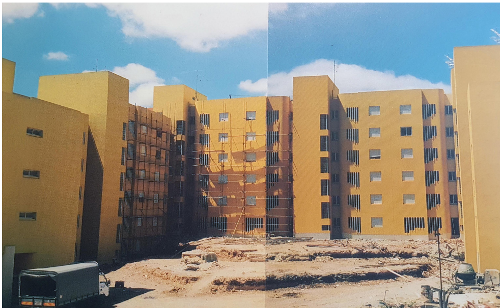
Figura 7 -- Bairro novo em construção – interior de uma praça com as cores originais. Fonte: Boletim do GTH. Lisboa, nº 52, 1990
