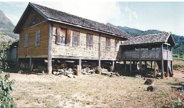
Figura 6. Casa rural da região do Caparaó. Vedações com pau-a-pique caído. Foto Luiz Antônio Pacheco Figura 7. Arquitetura com baixo custo na mesma região do Caparaó. Foto: Luiz Antônio Pacheco
