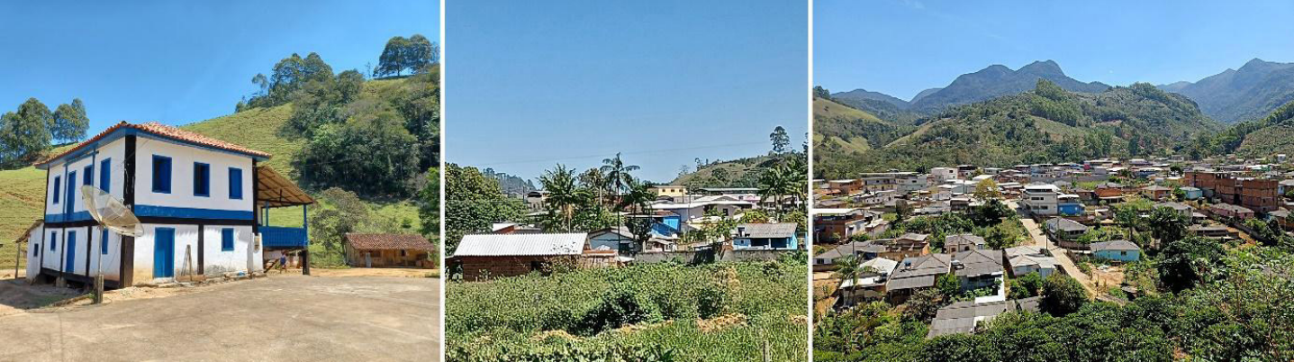
Figura 9 - Santa Marta. Degradação da arquitetura rural tradicional, cedendo lugar para o amianto e cobertura metálica. Foto: João Wesley de Souza.
