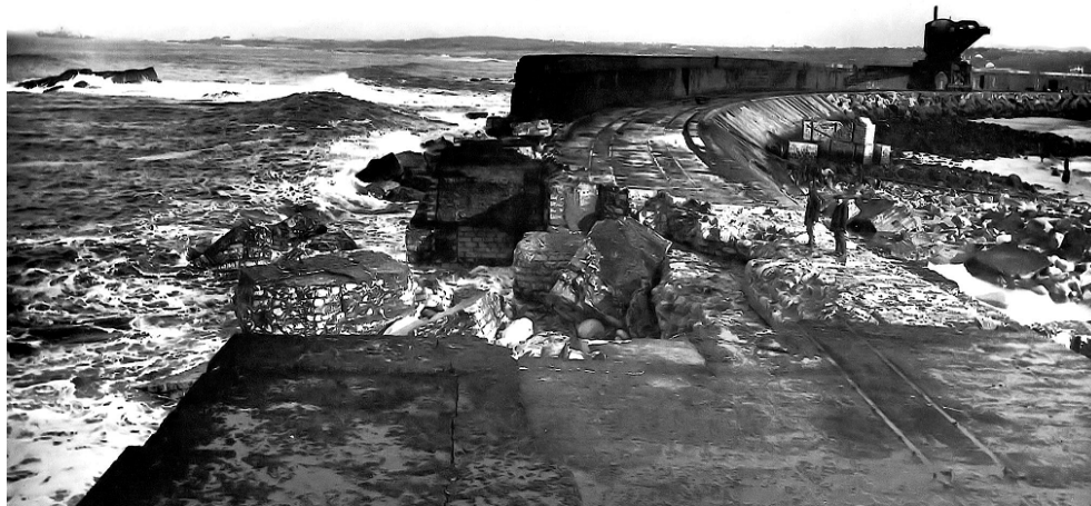
Figura 5. Efeitos do temporal de 1911 nos molhes do Porto de Leixões, Fonte: APDL
