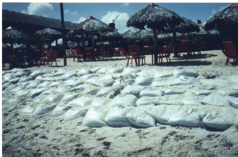
Figura 3 - Sacos de areia para tentando evitar o avanço do mar (jan/99).
