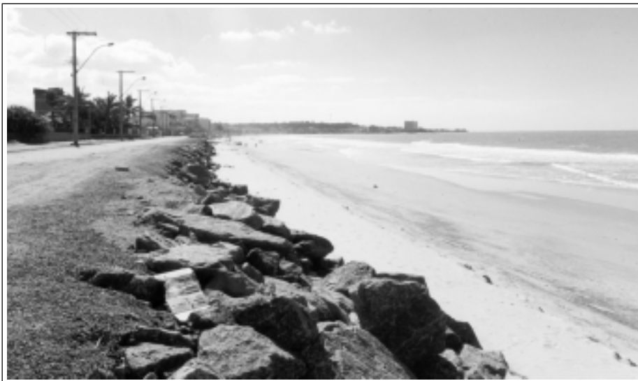
Figura 4 Praia de Marataízes, Marataízes, ES – Avenida beira-mar com enrocamentos longitudinais a fim de conter o processo erosivo
