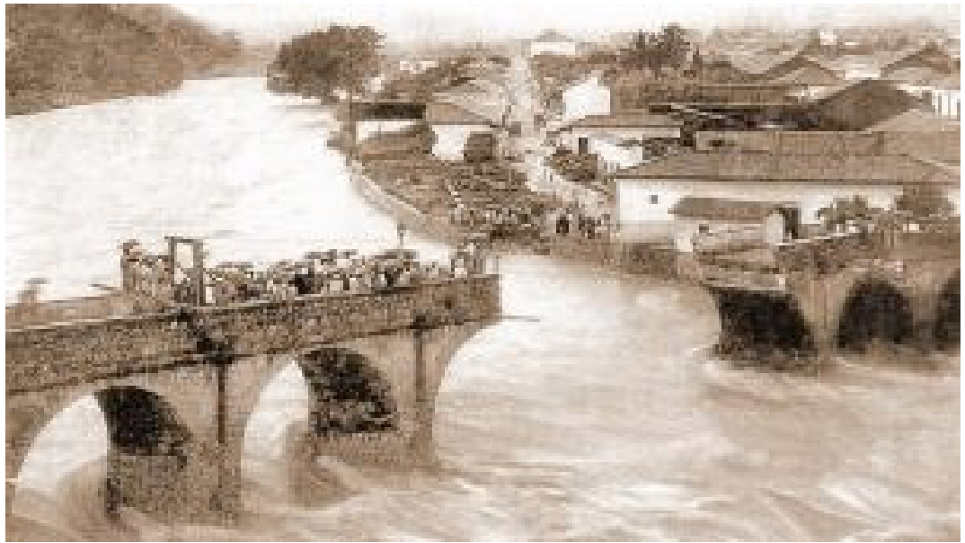
Foto 1: Daños causados al puente Mallol durante las lluvias de 1906. Se aprecia el sistema de poleas y cuerdas para el traslado de personas de un extremo al otro que se hacía en una gran canasta. Fuente: HISTOHONDURAS, 2012.
