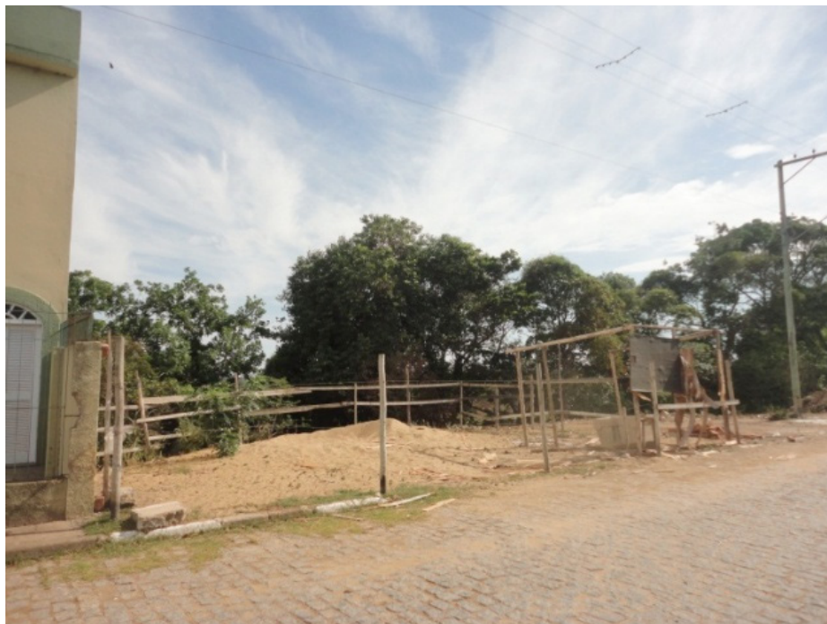
Figura 5: Essa foto, de 2015, é do mesmo local da anterior (fig.3), note-se que não tem mais o barraco e os arames farpados não existem mais. A construção que aparece ao lado é uma das igrejas que funcionavam no local e se encontrava abandonada. Pohlmann/LEEA/CCH/UENF.
