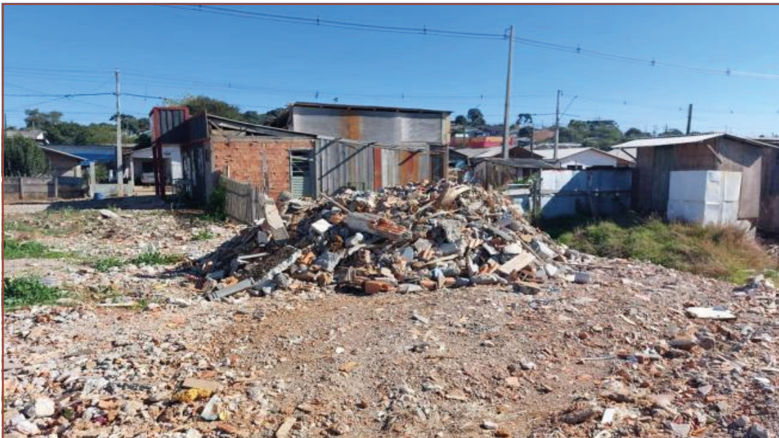
Figura 7 – Aterramento para construção em área de perigo de inundação
