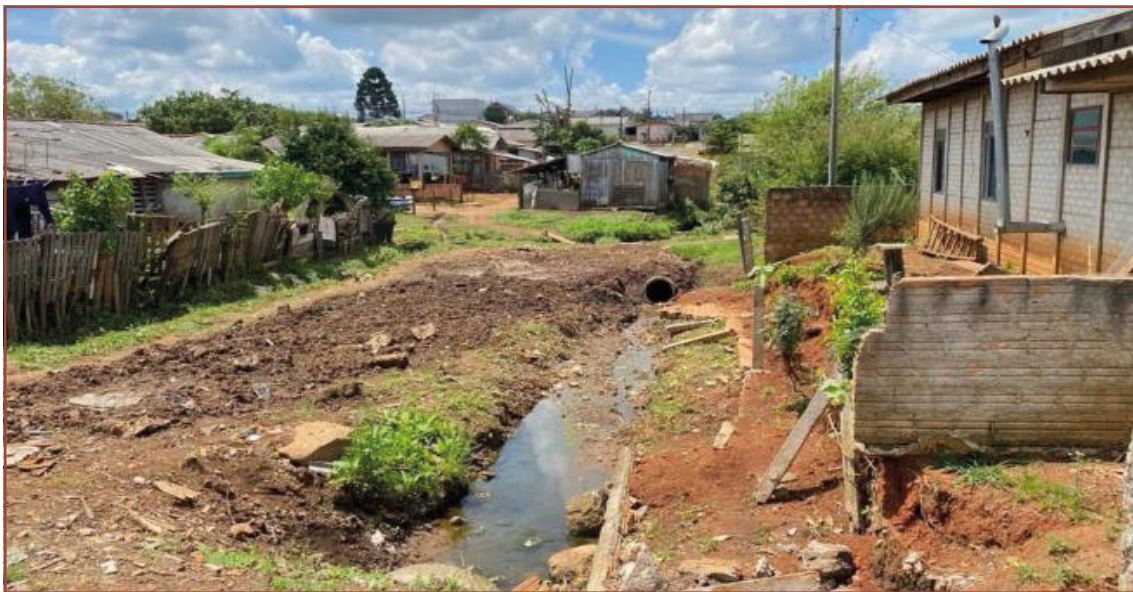
Figura 12 – Manilha de drenagem em APP (Vila dos Brasileiros)
