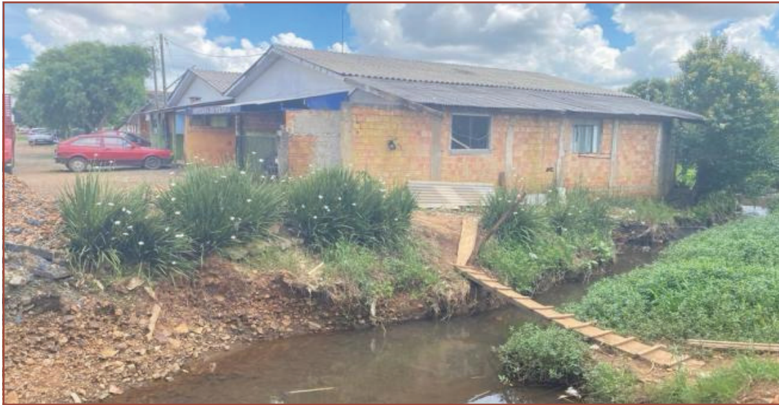
Figura 11 – Ponte de atravessamento no Rio Pioko (Vila dos Brasileiros)
