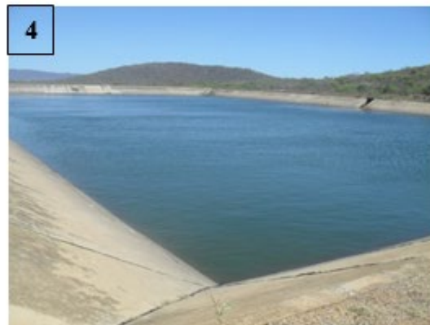
Figuras 2, 3 e 4: Agrovila, Rede de Canais de Irrigação e Reservatório do Perímetro Irrigado de Pau dos Ferros (RN).
