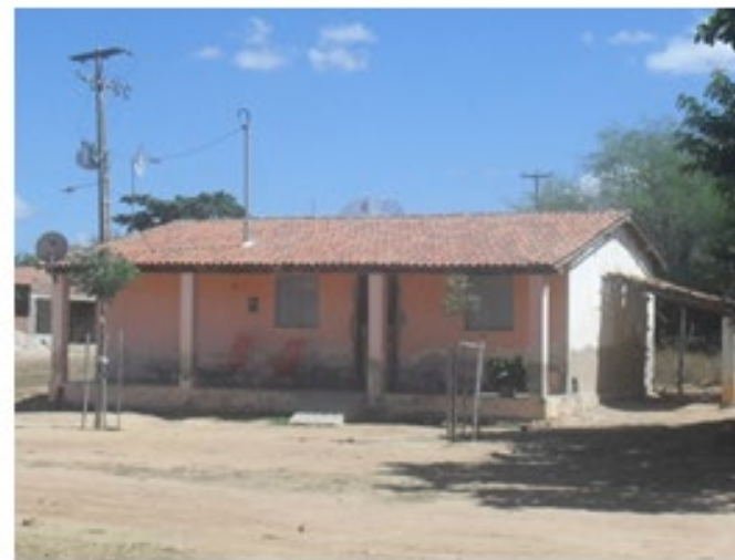
Figura 7: Casa Padronizada do Perímetro Irrigado. Fonte: Pesquisa de Campo (2012).
