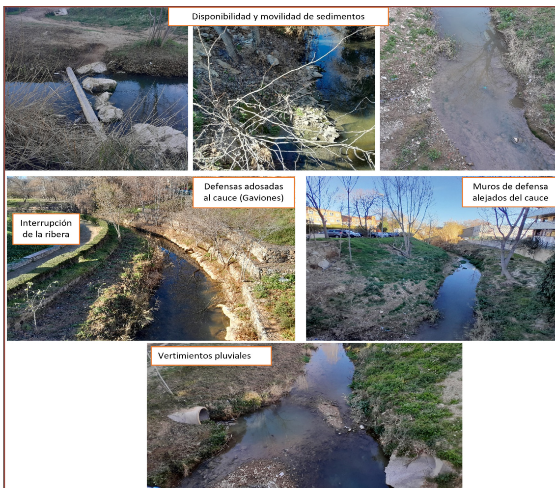
Figura 10 – Evidencia de alteraciones de la calidad hidromorfológica en el Tramo 1 “ZPU de Zaragoza”, en el río Huerva. Fotos tomadas por los autores
