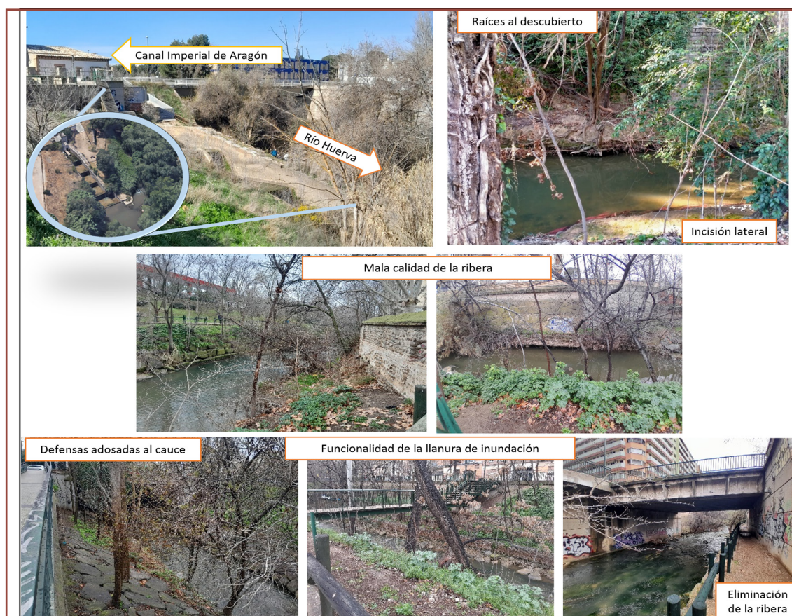
Figura 11 - Evidencia de alteraciones de la calidad hidrogeomorfológica en el Tramo 2 “ZU de Zaragoza”, en el río Huerva. Fotos tomadas por los autores (2025)
