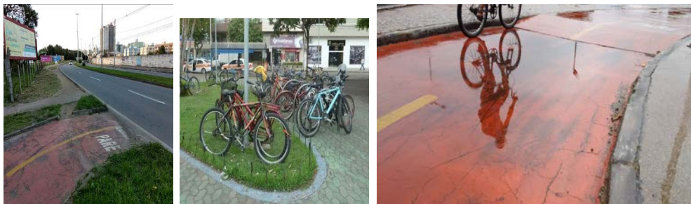
Figura 02 A esquerda, descontinuidade da via; ao centro, exemplo de poucos estacionamentos para bicicletas; e à direita, drenagem ineficiente. Fonte: Acervo da pesquisa.
