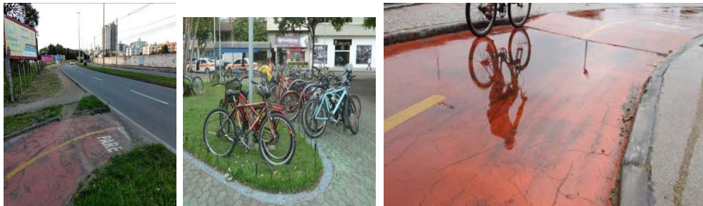
Figura 02 A esquerda, descontinuidade da via; ao centro, exemplo de poucos estacionamentos para bicicletas; e à direita, drenagem ineficiente. Fonte: Acervo da pesquisa.
