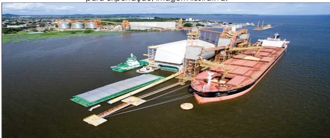
Figura 1 - Embarque dos grãos em navios por meio do sistema de carregamento para exportação, imagem ilustrativa.
