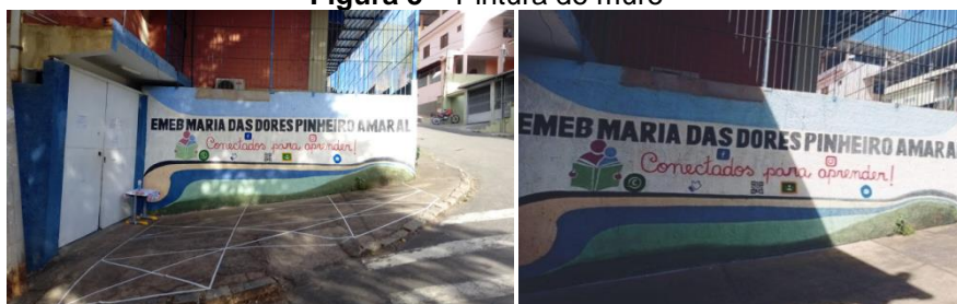
Figura 5 – Pintura do muro
