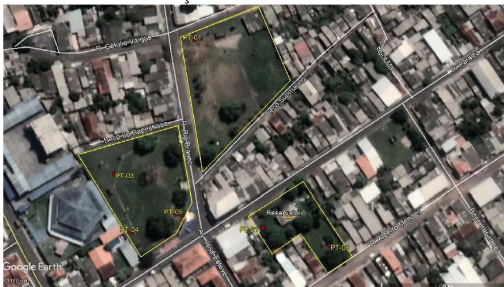
Figura 2: Área em que se encontram os 6 poços em atividade na estação de bombeamento I
