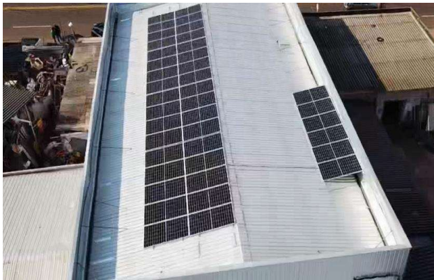
Figura 3. Instalação dos painéis fotovoltaicos em Campo Grande MS.
