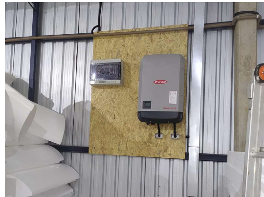
Figura 4. Instalação do inversor fotovoltaico e string box em Campo Grande MS.
