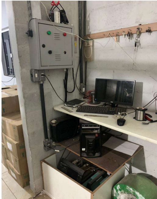
Figura 9. Introdução de bobinas de transformadores na máquina CNC (parte inferior da imagem).
