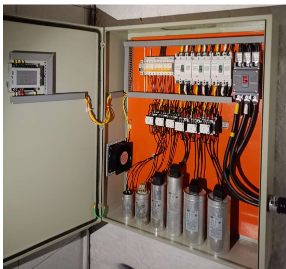
Figura 1. Quadro do banco automático de capacitores instalado na Empresa A.
