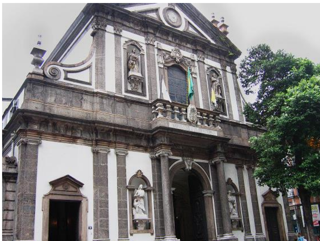
Fachada da igreja de Santa Cruz dos Militares
