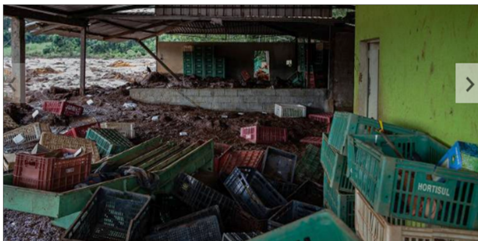
Figura 1: Lama destruiu casas e plantações na região da Horta, que fica entre Tejuco e Parque da Cachoeira, em Brumadiho (MG). Foto: Eduardo Anizelli
