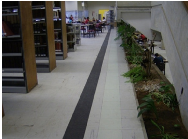
Figura 1 – Pavimentos táteis de alerta no interior da BCZM
