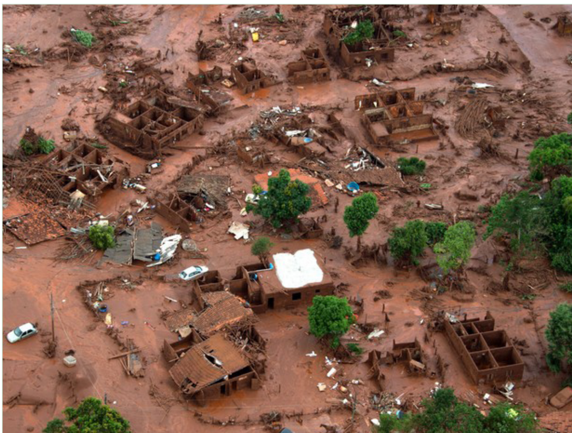
Figura 1 - Distrito de Bento Rodrigues recoberto por rejeitos da barragem
