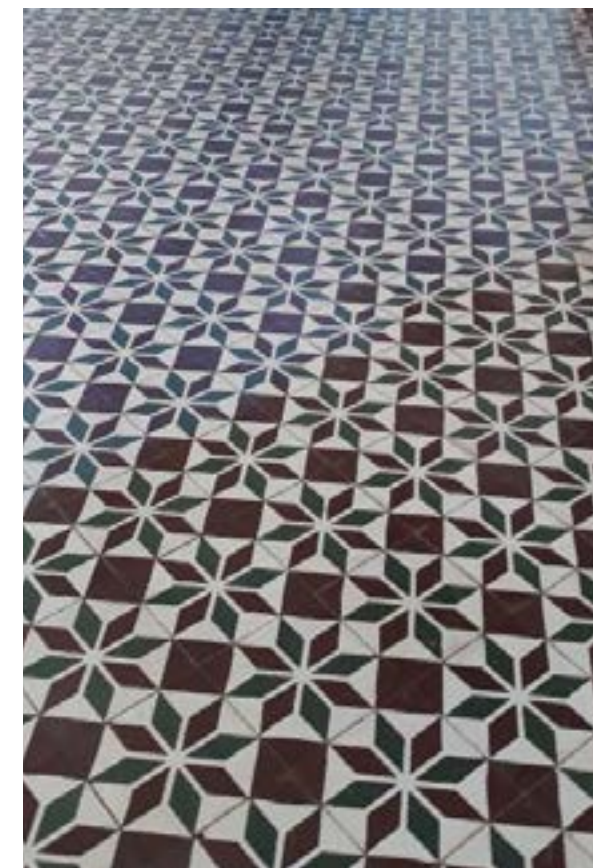
2: Pormenor do ladrilho hidráulico da Capela de Nossa Senhora da Penha. Foto do autor, 2017.
