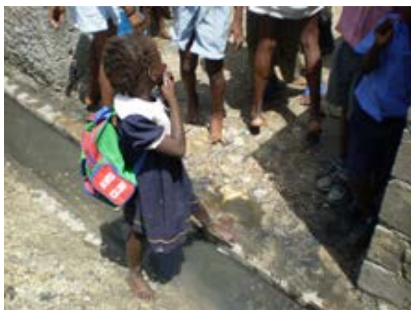
Figura 2 - Cité Soleil (2006-2008), Port-au-Prince, Haiti. Detalhe do sistema de esgoto. As casas não possuem encanamento e os dejetos da cozinha e banheiro são depositados nesta vala ao lado das moradias, gerando riscos de saúde aos moradores. Foto: SD. Pablo Sales Almeida.
