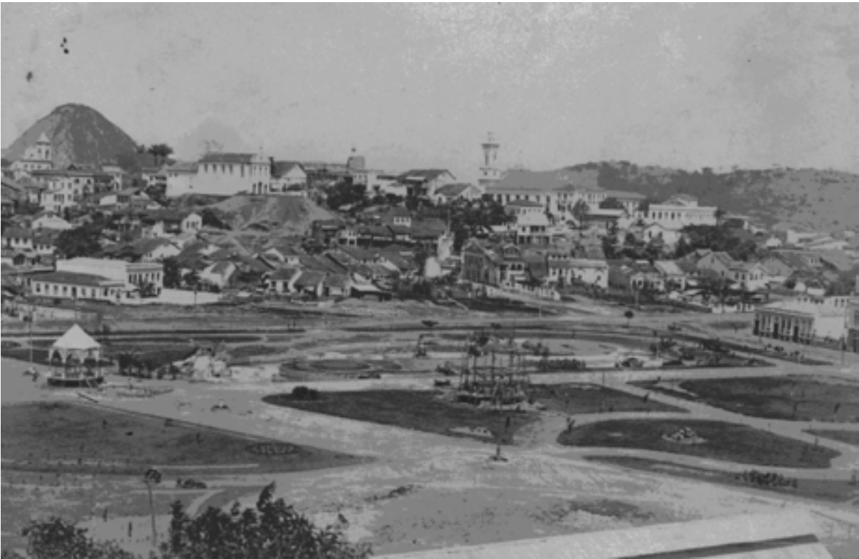
Figura 10 - (AJM-05) Parque Moscoso ainda em fase de conclusão das obras, s/d. Fonte: Coleção fotográfica 'Jerônimo de Souza Monteiro' (APEES).
