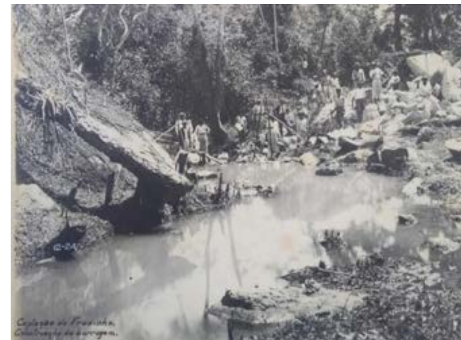
Figura 5: Captação em Fradinhos. Fonte: Arquivo Público do Município de Vitória
