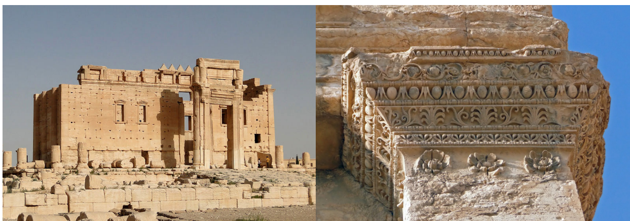
Figura 4 – Entablamento de la fachada principal y detalle de capitel de pilastra imitando el esquema del entablamento
