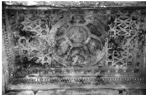
Figura 7 – Techo del tálamo norte
