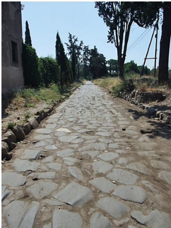
Figura 1 - Via Appia com a pavimentação original
