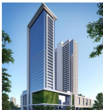
Figura 3: Complexo Multiuso Humany Fonte: Fibra Construtora
